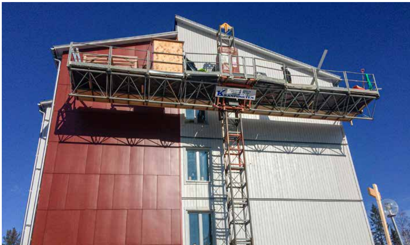
Montage av fasadsystemet från byggplattformen.
