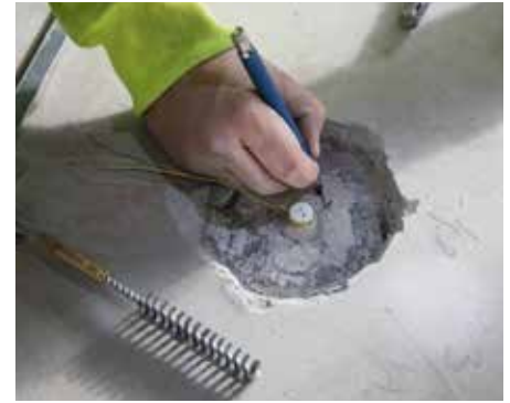
Mätstationen skyddas med ett lock.
