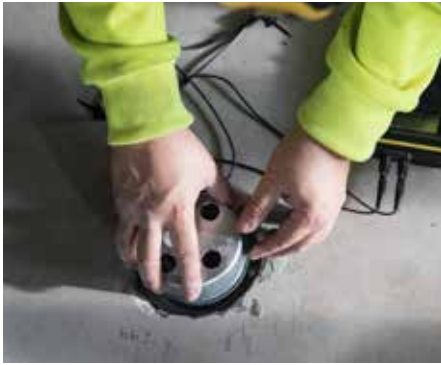
När avjämningsmassan tagits bort monteras foderröret och tätas, littrnummer noteras.
