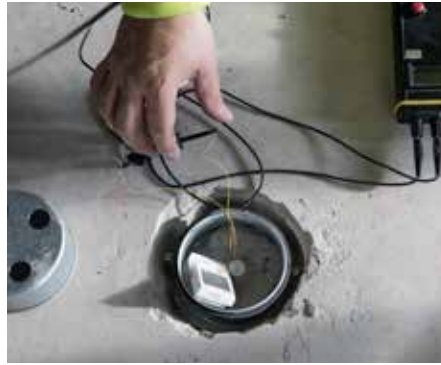
Temperaturlogger monteras och givaren funktionsprovas.
