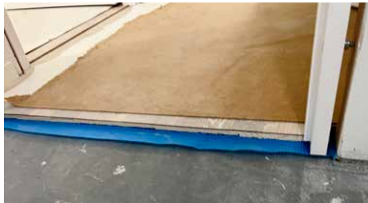
Parkettgolvt lagt på räfflad underlagsfoam med ångspärr på ena sidan.
