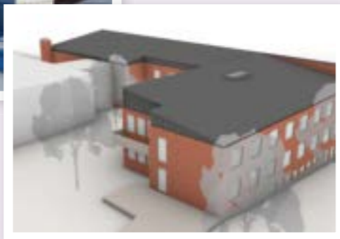
Arkitektförslaget på ny takutformning för att skapa ett tak för minskat underhåll och klart förbättrade möjligheter för en effektiv solcellsinstallation.
