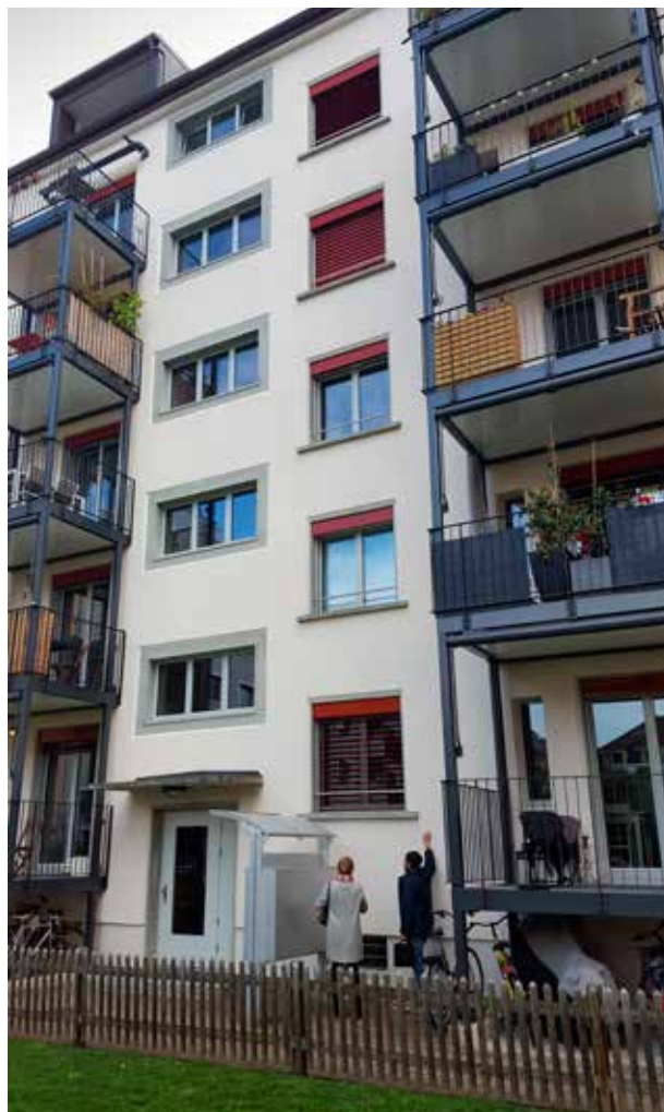
Byggnad i Zürich, Schweiz, med superisolerande puts på utsidan, fotot från besök 2019.
