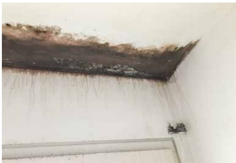
Bild 1. Mögeltillväxt i vägg-takvinkel i badrum i lägenhet med väldigt hög boendetäthet.
