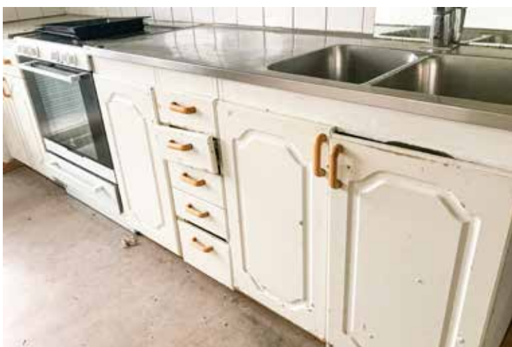
Bild 2. Hög slitage på kök i en lägenhet som haft väldigt hög boendetäthet.
