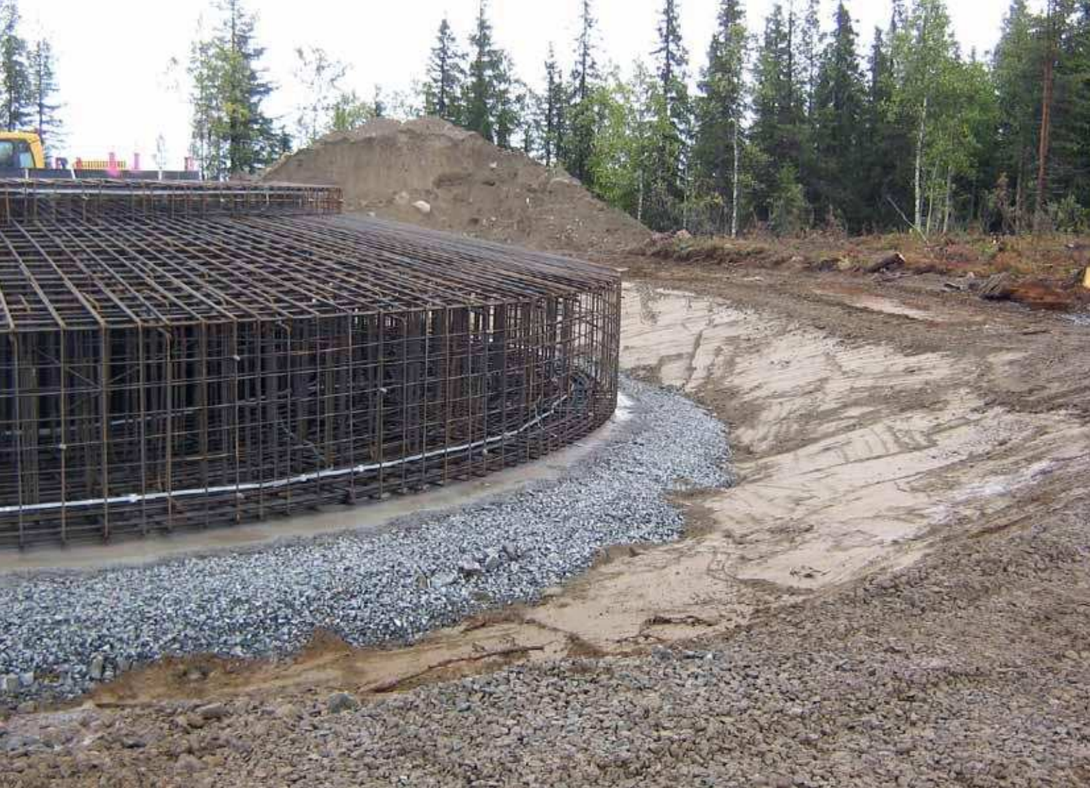
Fundamenten till vindkraftverk blir rejält armerade. Foto: Enercon
