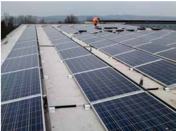
Projekt 1. Plant tak med solcellsmoduler monterad på en ny takduk.
