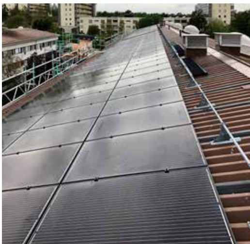
Projekt 3. Lutande plåttak med solcellsmoduler monterad efter takförstärkningar.
